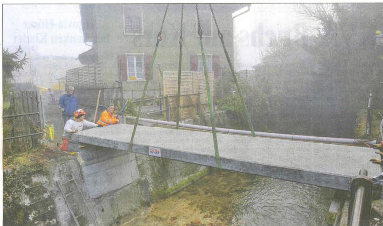
Fünf Tonnen Beton und Stahl am Autokran
