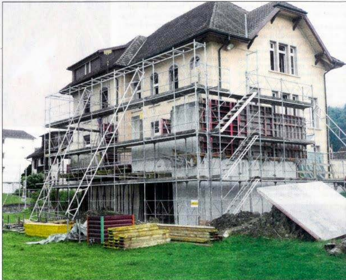
Ein Schuljahr von Bauarbeiten geprägt: Das Primarschulhaus in Pfeffikon wird umgebaut.
