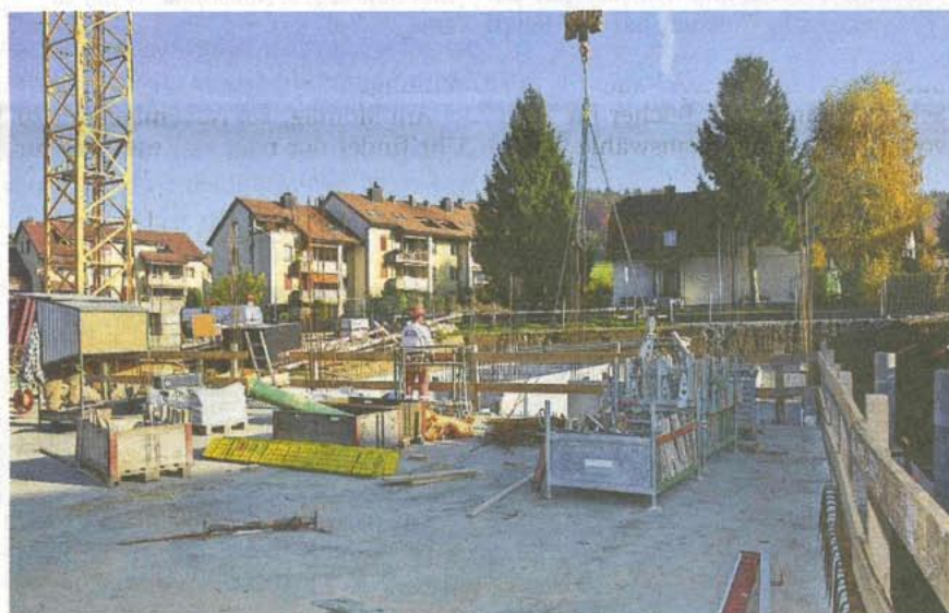
WOHNHÄUSER KIRCHENBREITE Die Tiefgarage steht zu zwei Dritteln; Bauarbeiter Koca Norton befreit Schalungselemente von Betonresten.
