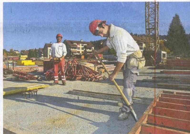
WOHNHÄUSER KIRCHENBREITE Die Tiefgarage steht zu zwei Dritteln; Bauarbeiter Koca Norton befreit Schalungselemente von Betonresten.
