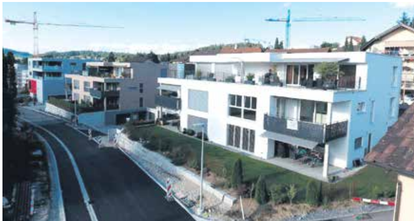
Zurückversetzt: Die beiden reinen Wohnhäuser sind von der Hauptstrasse abgewendet.
