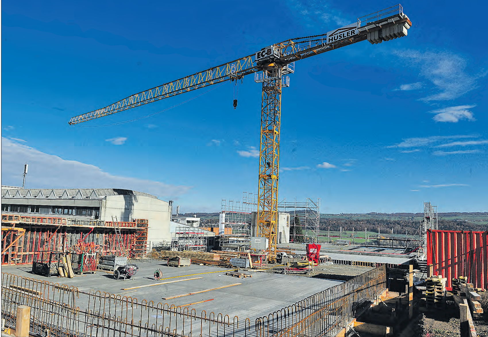
Der Neubau für das Bauamt und Feuerwehrmagazin in der Widenmatt Beinwil am See ist auf Kurs: Ende November kann der Rohbau voraussichtlich aufgerichtet werden. (Bild: msu.)
