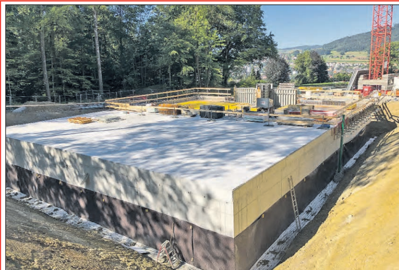
Imposante Anlage: Das neue, 2000 Kubikmeter fassende Wasserreservoir im Reinacher Sonnenberg. Vom Bauwerk selber wird später nicht mehr viel sichtbar sein. (Bilder: msu.)
