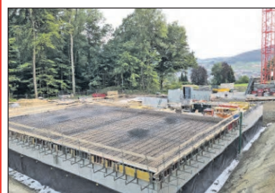
Die Eisen sind verlegt, noch fehlt der «Betondeckel».
