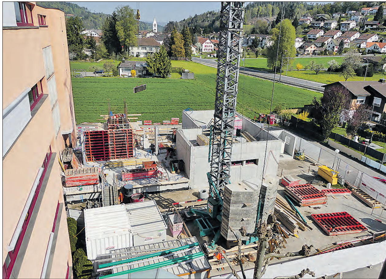
Der Anbau wächst: Im Juni soll der Rohbau fertiggestellt sein. Ende Dezember will die Spitex Mittleres Wynental am neuen Domizil beim Alterszentrum Oberkulm einziehen. (Bild: moha.)
